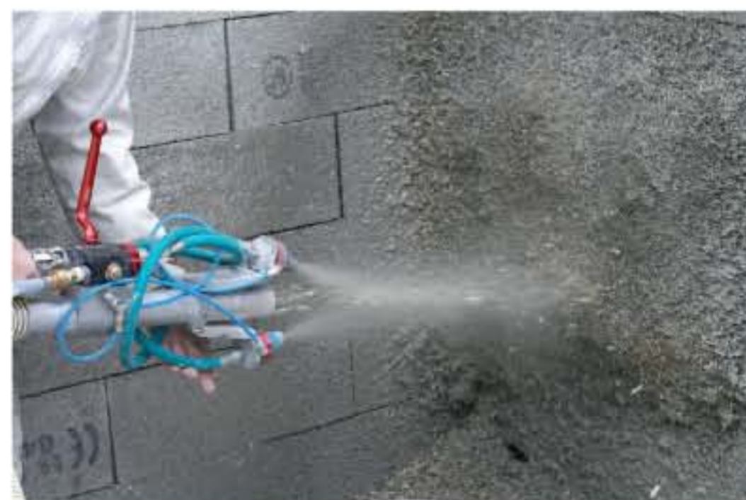
Projection de chanvre et de lait de chaux
